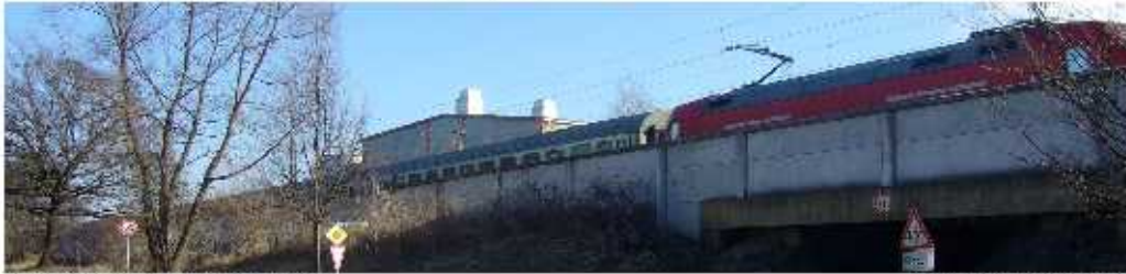
Festlieger Fahrflüschutz am Industriegebäude
