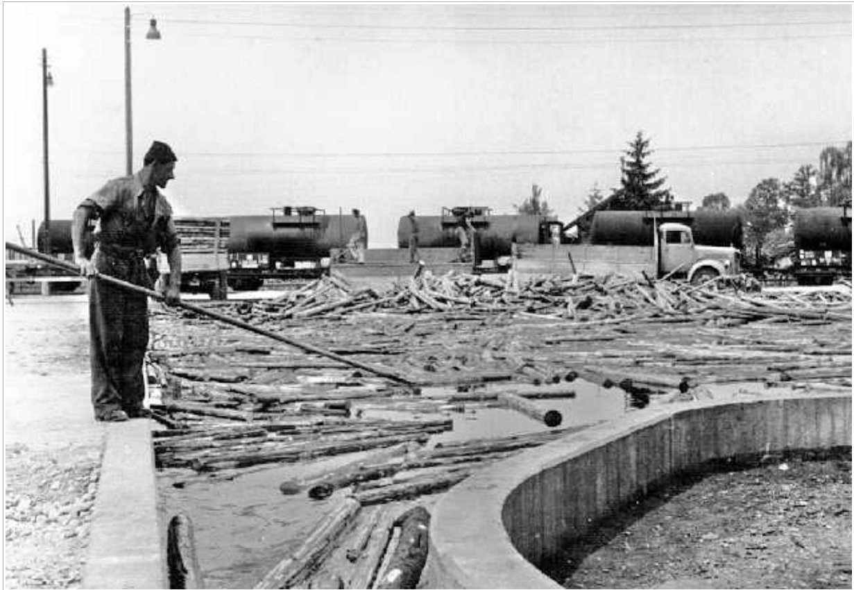
Trommelentrindung, hier Wässerungsbecken, 1958
