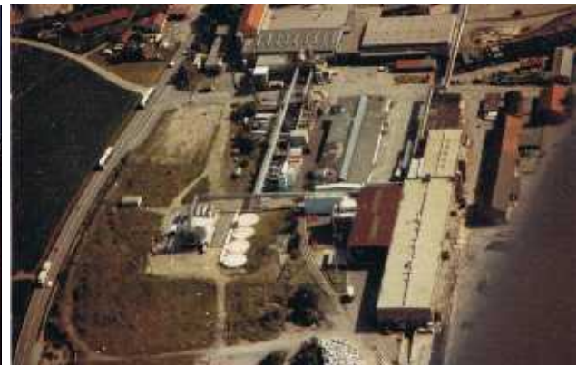
Luftansicht Werk Raubling (Oktober 1984)
