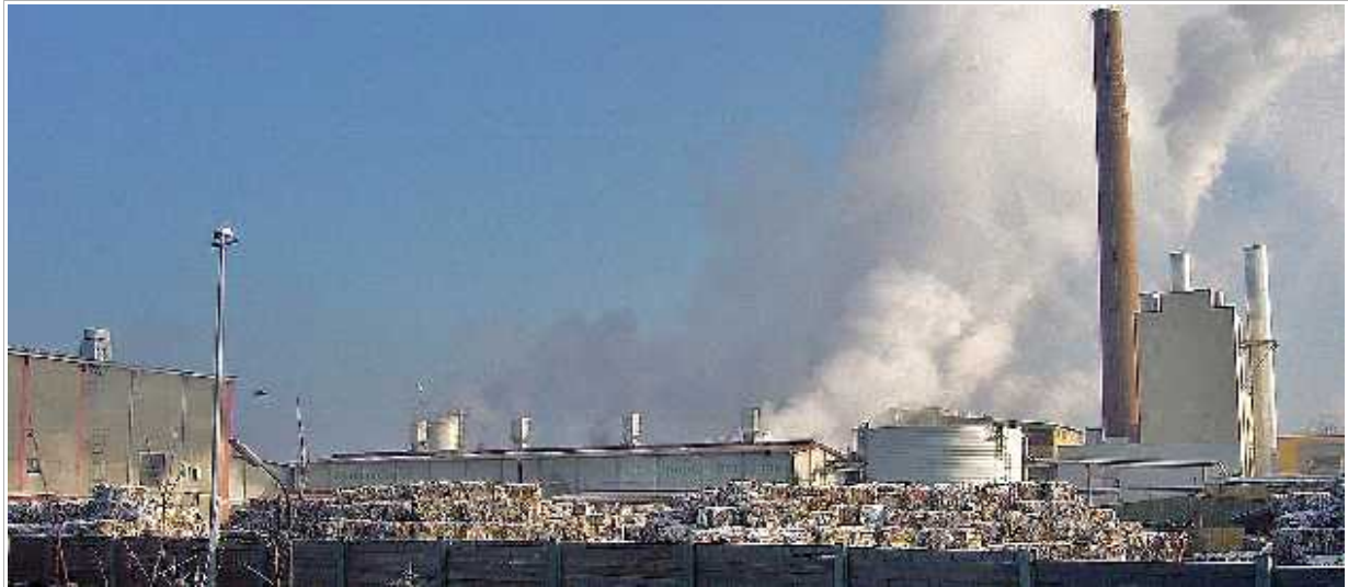
Mondi - Packaging , Altpapier- und Verbundpapieraufbereitung, Kläranlage, Kraftwerk, 2009
