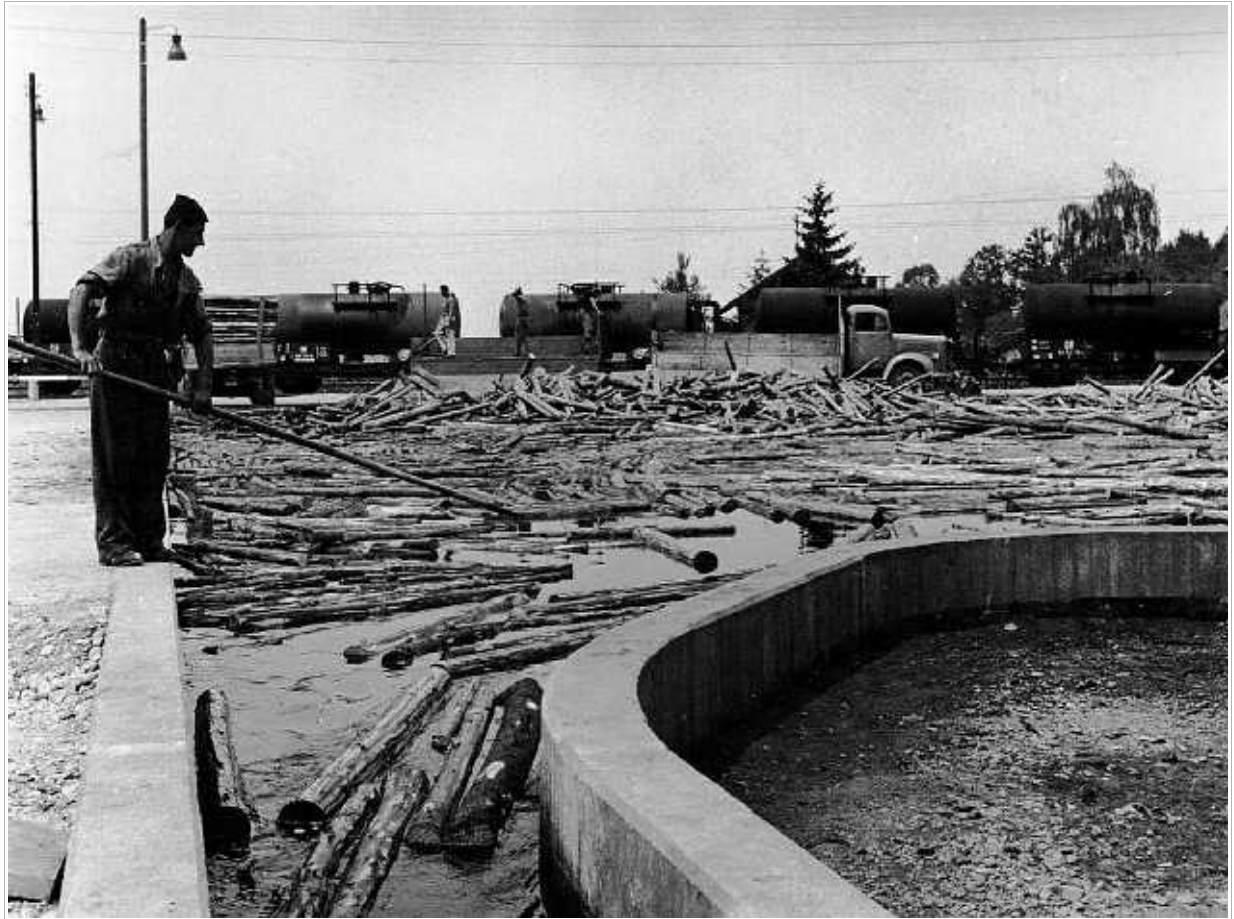
Entrindungsanlage, hier Wässerungsbecken, 1958
