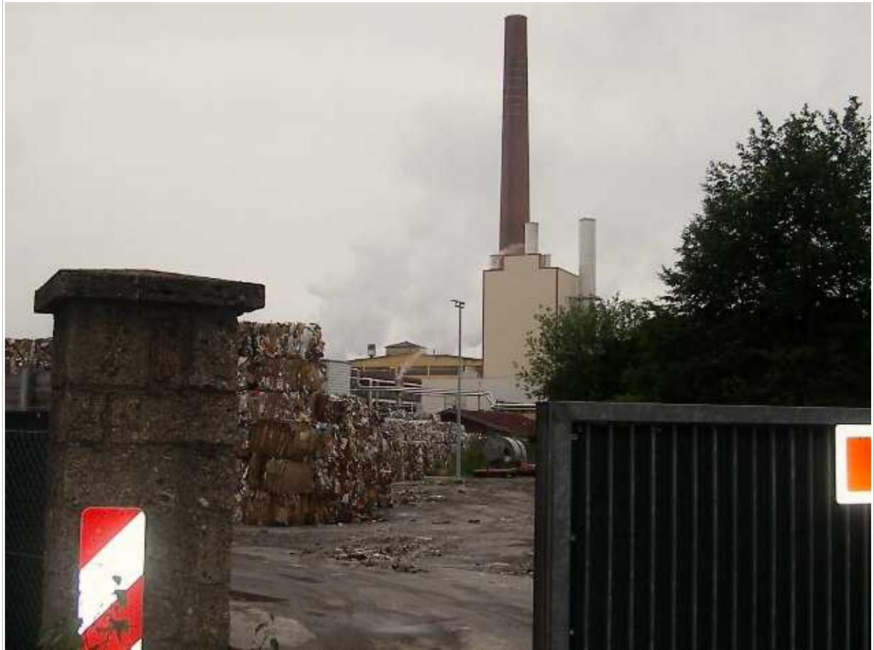
Mondi Packaging - Biologische Kläranlage, ausreichend für 150.000 Einwohnereinheiten, Abwassereinleitungstemperatur in den Inn = 38 Grad
