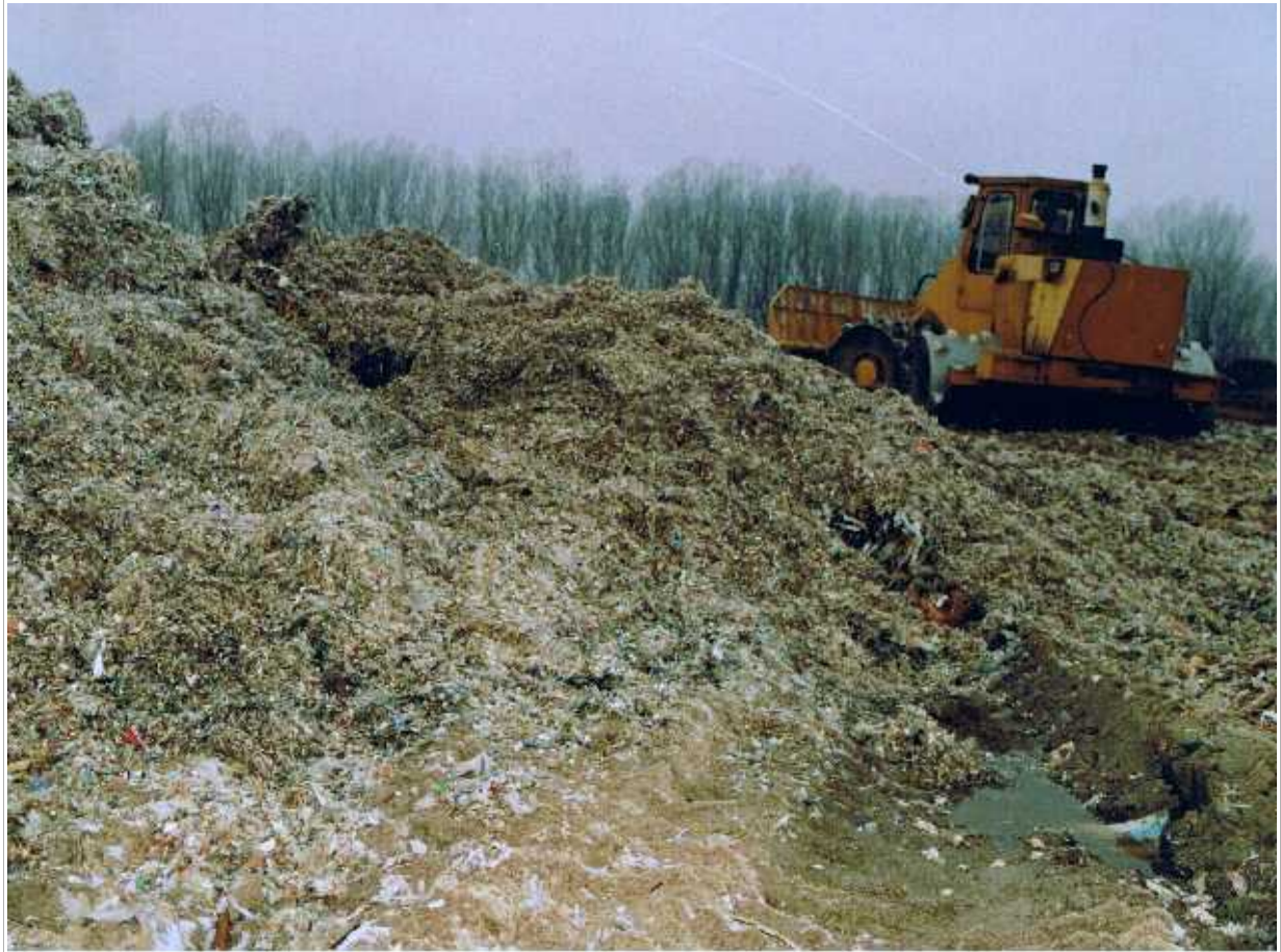
PWA - Betriebsdeponie, unzulässige aber behördlich geduldete Entsorgung u. a. der nicht verwertbaren Alu- und Kunststofffraktionen aus der Verbundpapier-Aufbereitung, 1992
