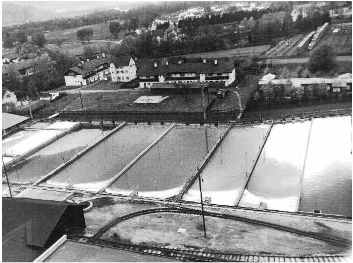
Absetzbecken der Industrieabwässer, 1958
