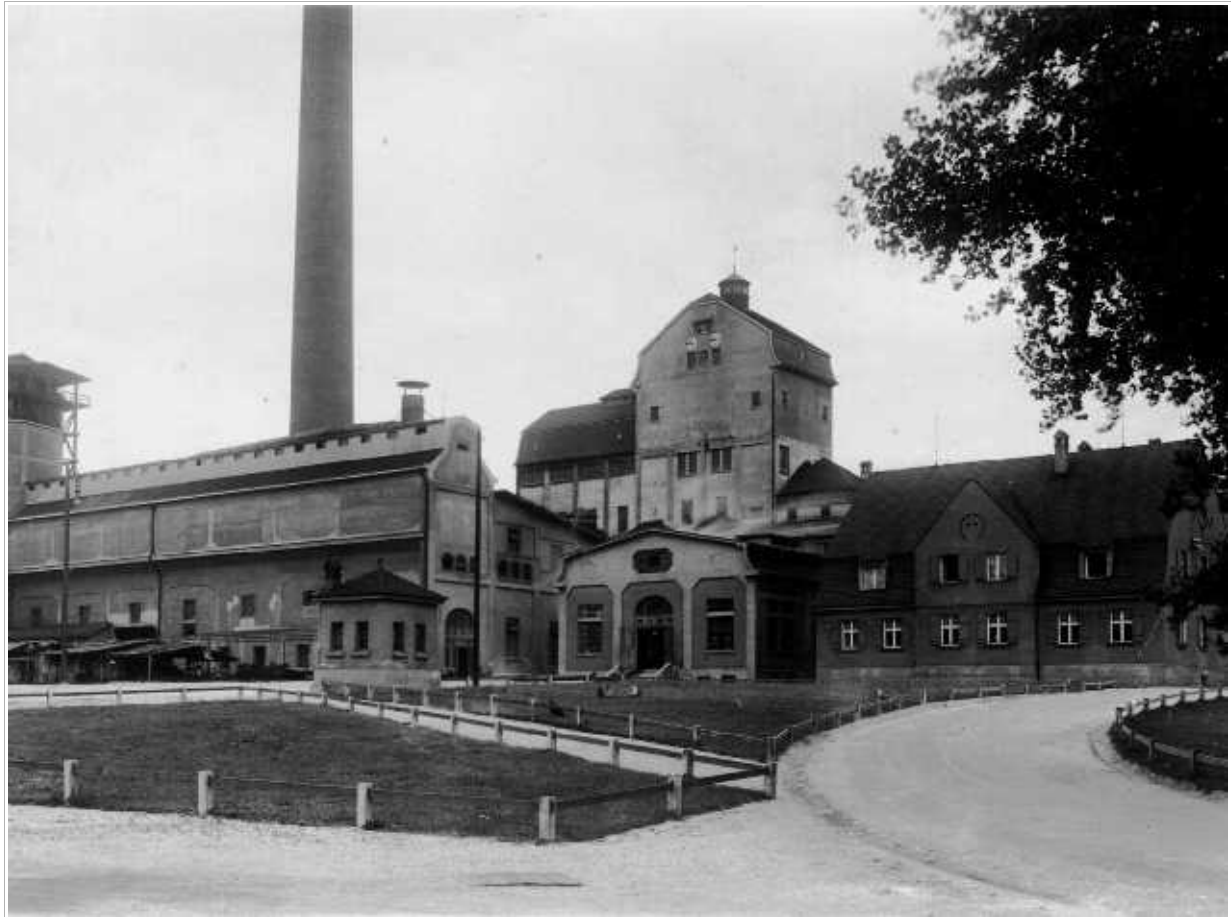
Kraftwerk mit Zentrale und Direktionsvilla, verm. Anfang der 1940er Jahre
