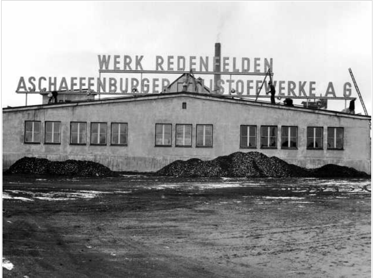
Bau der Duro-Huxol Tütenfabrik, heute PharmaZell Produktionsgebäude, 1955
