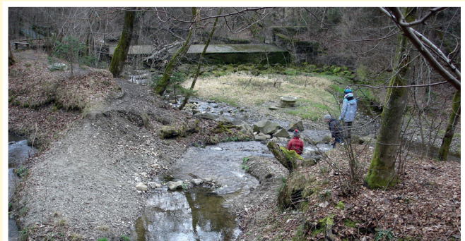
Exkursion zum Finsterwaldergelände - hier die neue Fischtreppe 2014
